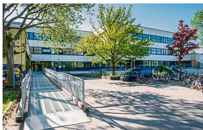
Zuletzt waren die Schulen gespenstisch leer. Fotos: Uwe Weiser
